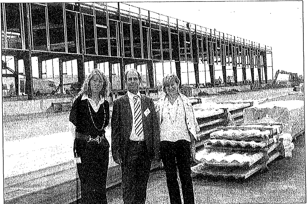
Christophe Schmitt, directeur de la région Est, chez Heppner et ses collaboratrices, devant la nouvelle agence en cours de montage sur le Pôle Eurotransit d'Ennery. Photo RL
