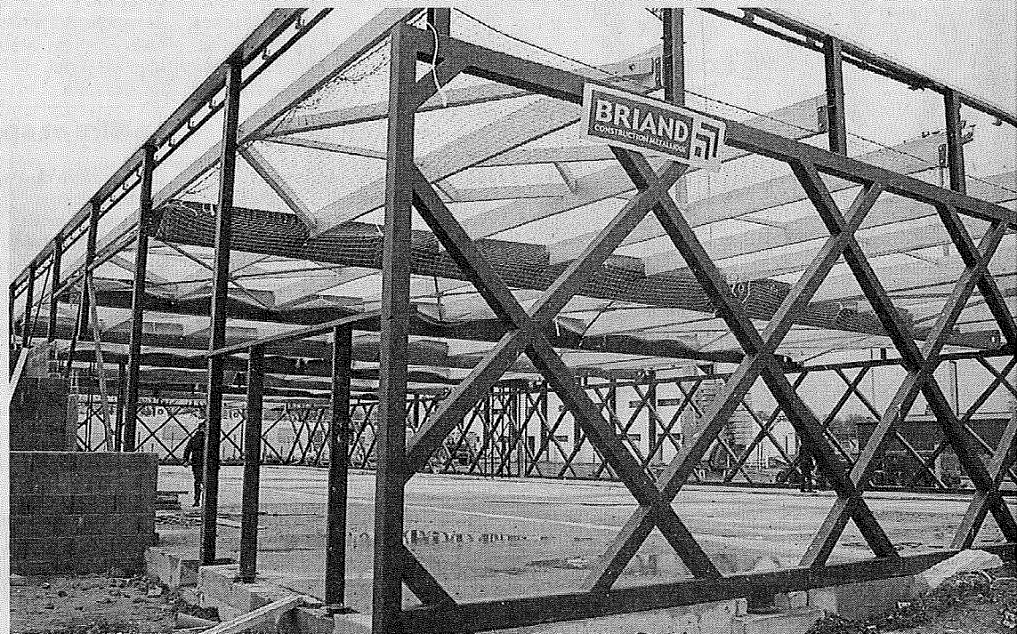
Le dojo en construction avenue Massabielle est l'un des deux grands équipements sportifs qui verront le jour cette
